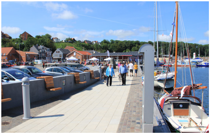
Højvandsmuren i Lemvig Foto: Kystdirektoratet
