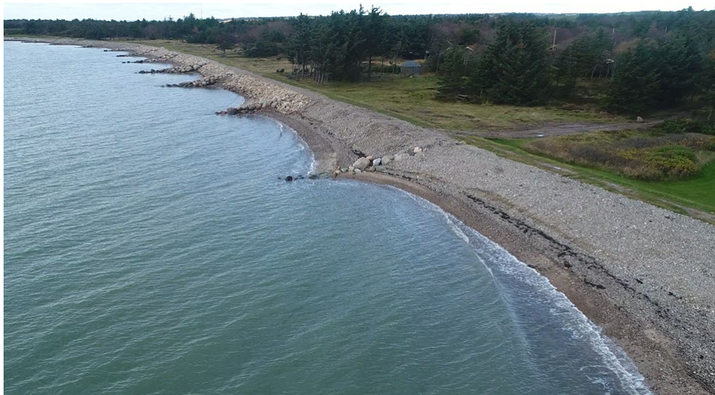
Figur 5.9 Dige beliggende på forstrand udsat for erosion
