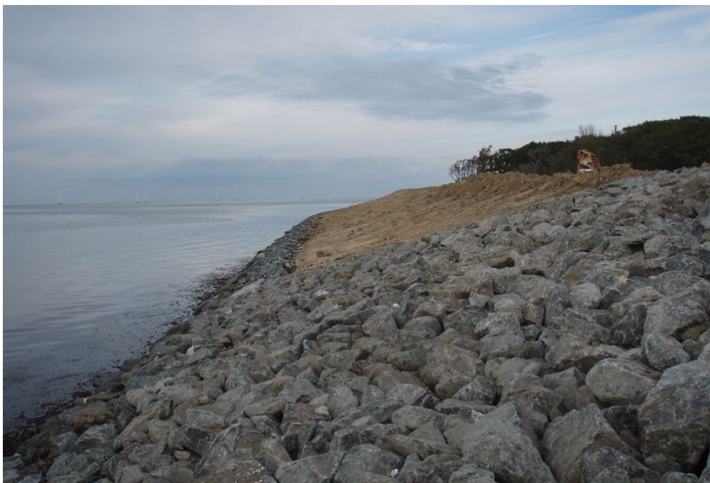
Figur 5.6 Meget kystnært placeret dige med fodbeskyttelse af sten, Nord for Tårs Lolland
