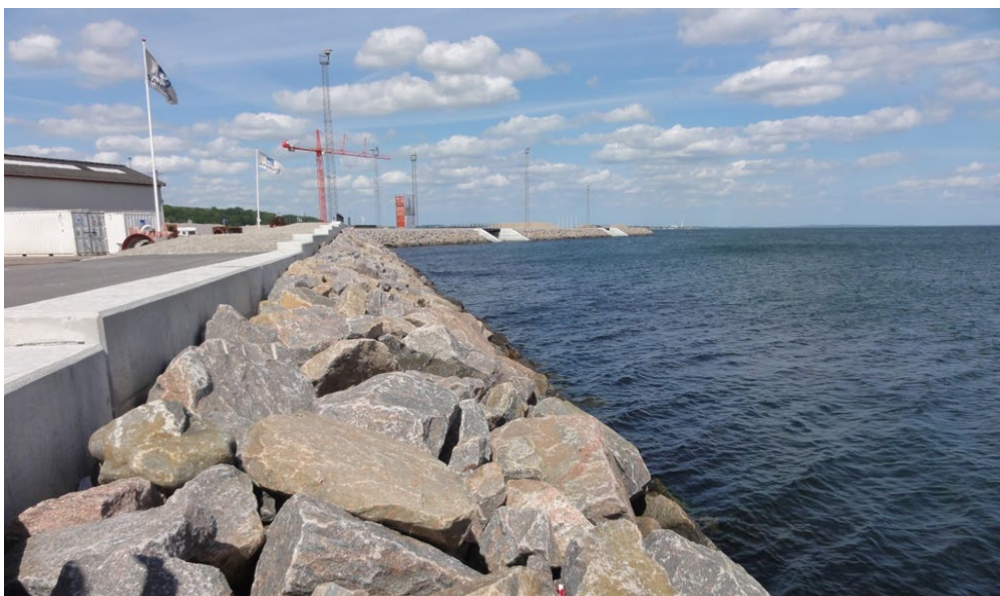
Figur 5.3 Bølgebrydende skråningsbeskyttelse med undersøisk banket
