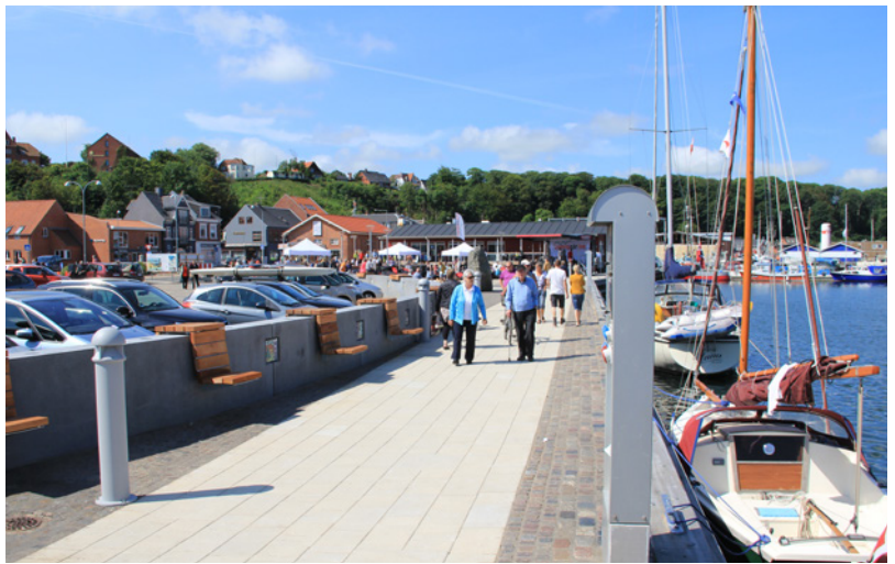
Højvandsmuren i Lemvig Foto: Kystdirektoratet
