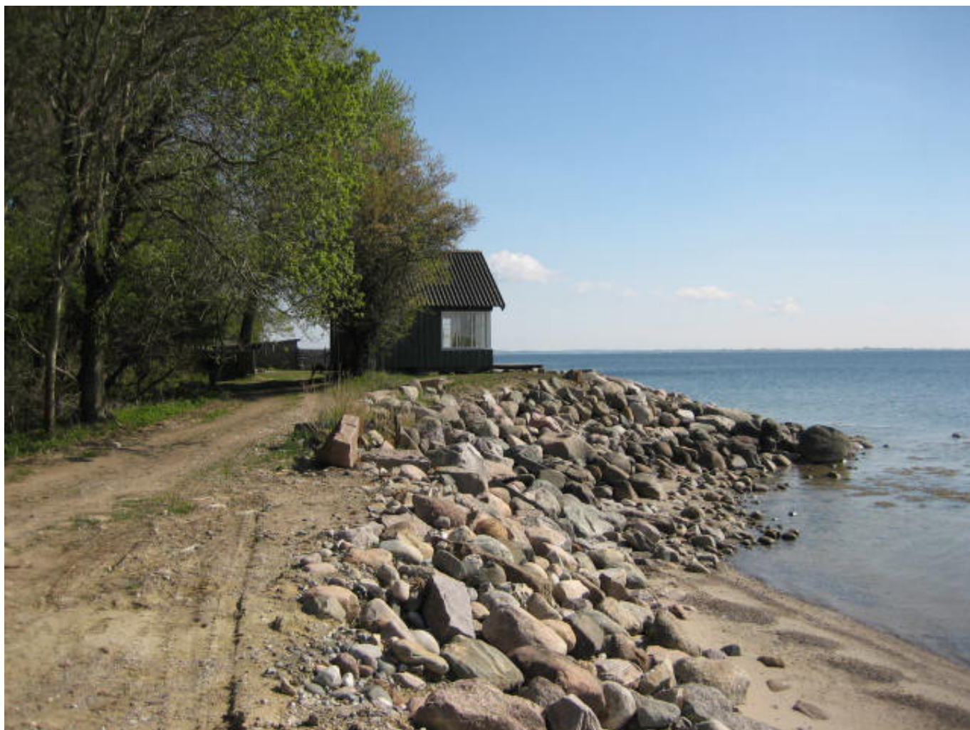
Skråningsbeskyttelse, Foto: Kystdirektoratet
