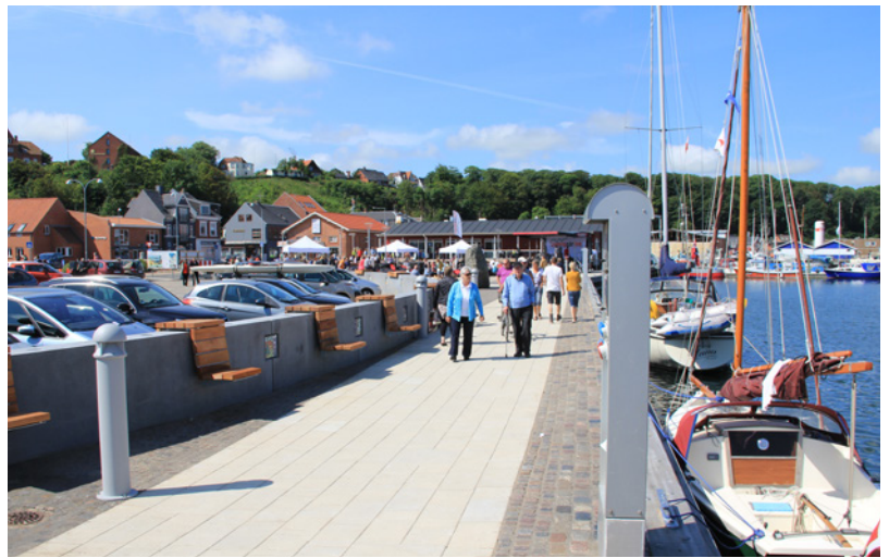
Højvandsmuren i Lemvig Foto: Kystdirektoratet
